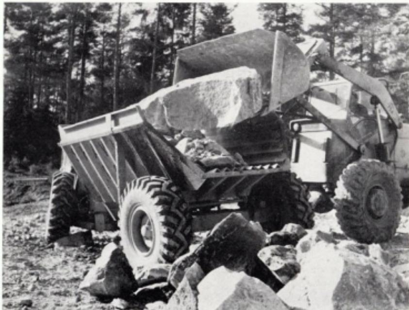
*Shawnee-Poole traktordumper är på grund av sin längd lämplig att lasta med skopplastare. Bilden är tagen från Nils P. Lundbs motorvägbygge Västerås—Köping, där 9 Shawnee-Poole arbetar med transporter av berg- och schaktmassor. Transportcykeln är 8 km inklusive återfärd. Körningen sker dels i svår terräng och delvis på allmän väg.*
