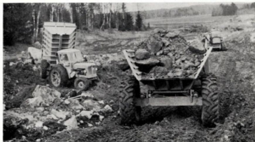
*Shawnee-Poole är konstruerad för att övervinna rullningsmotstånd — de stora enkelmonterade hjulen, de stora kraftiga däckens och den speciella kopplingen, som flyttar över tyngd på drivhjulen, underlättar framkomligheten i terräng.*
