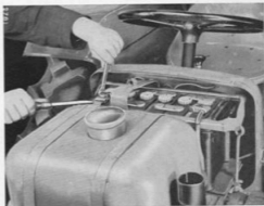
Bild 50. Bortkoppling av anslutningarna. Tag alltid bort jordledningen först. Lossa klämbultarna och bryt bort kabelskon från batteripolen med en skruvmejsel.
