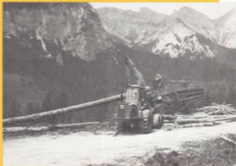
Helstammetoden tillämpas även i Österrikes alper och där sker kvistning-kapning med ÖSA 705/260 processor.
