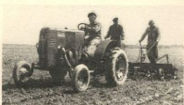
Spårvidden kan lätt ändras på BM-10, varför traktorn med fördel kan användas i radodlingar.
