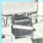
Batteriet har en kapacitet på 85 amp. tim. och spänningen är 6 volt. Det är lätt att kontrollera och sköta.
