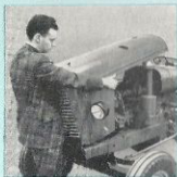
13 Motorhuv i ett stycke lätt demonterbar av en man på några sekunder.
