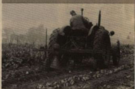
Fords »Rational» tvåradiga betupsptagare. Kan även användas för potatissupptagning.
