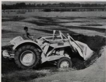
Einschürfen am Haufwerk
