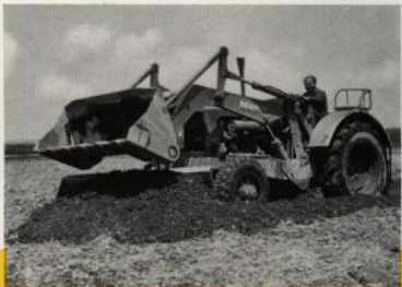
Arbeitseinsatz mit vorgesetztem Planierschild
