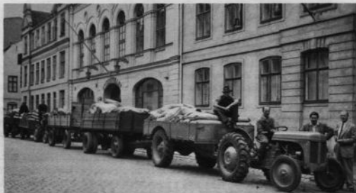
Kommer sådana här traktortåg att tillåtas i den nya förordningen? Den 1 100 kg tunga traktorn drar 10 ton socker tack vare att lasten från första enaxliga släpvagnen ger traktorn en »bruttovikt» av 2 100 kg.
