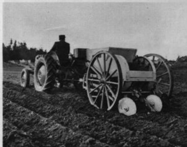
Prototypen av Overums välkända 2-radiga potatissättnare för traktordrift. Sättnaren har också kompletterats med konstgödelspridare för kornad superkali.
