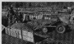
En Ferguson utrustad med specialskåp arbetar för två vid cementblandningen.
