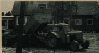
Vid det nya ålderdomshemmet i Kafjärdens storkommun tömmer en MF 65 med dumper fullnadsmaterial.
