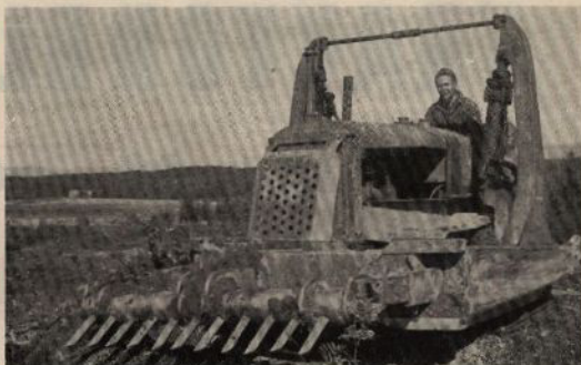
Bild 1. Allis-Chalmers Mod. K med hydrauliskt manövrerad stubbrivare.
