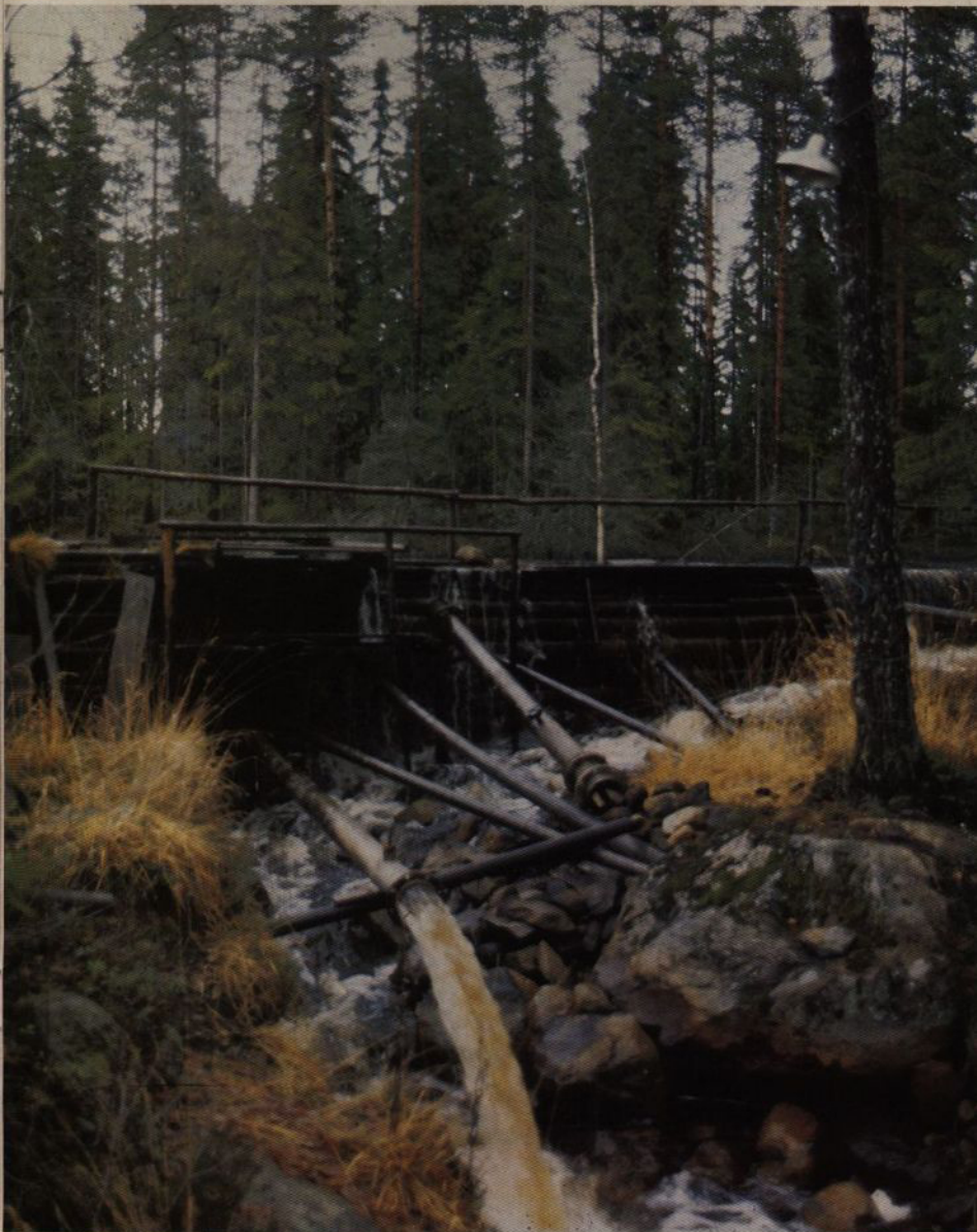
Nere vid dammen som Ivan byggt fanns en turbin som levererade ström till lampan i trädet och en närbelägen skogskoja. Turbinen var för tillfället borttagen
