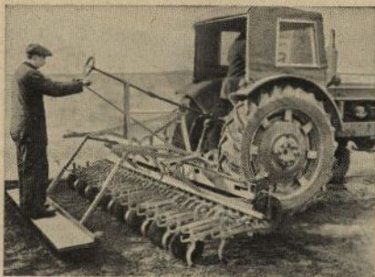
Här har vi hackat Hektor med gångbräda och styrtång. Den 9-radiga hackan har vridspak i stället för styrtång
