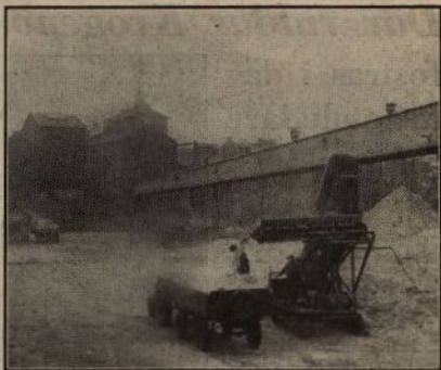
På inbyggda transportband försas betmassan ut från fabriken och lägges i en hög som fort smälter ihop. De flesta ekipagen tar hem betmassa på återvägen. Lastningen går smärtfritt med en transportabel lastare
