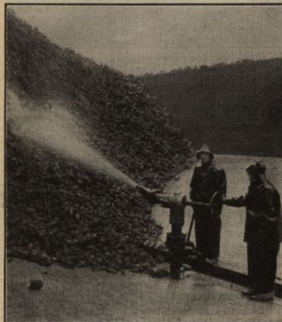
Med hjälp av vattenkanoner spolas betorna in i fabriken
