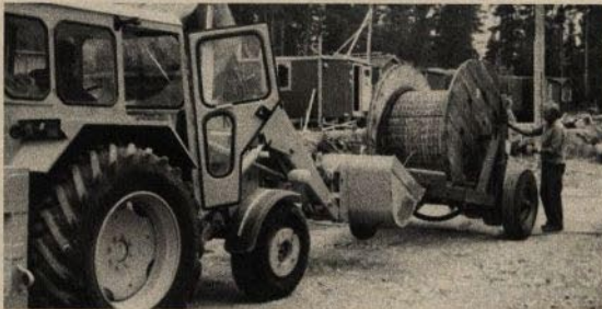
Arbetsuppgifterna för en MF-maskin är många. Här är kabeldragning på gång.
